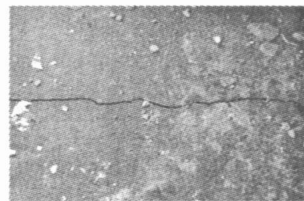
图 12 楼面裂缝图
