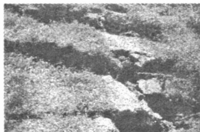
图 5 地面前下沉引起的裂缝图
