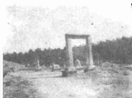
照片1 石门,断裂处在左上角及右柱处
